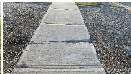
Spalling
